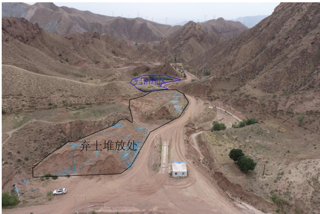
照片 2-4 已恢复治理区及弃土堆放处
